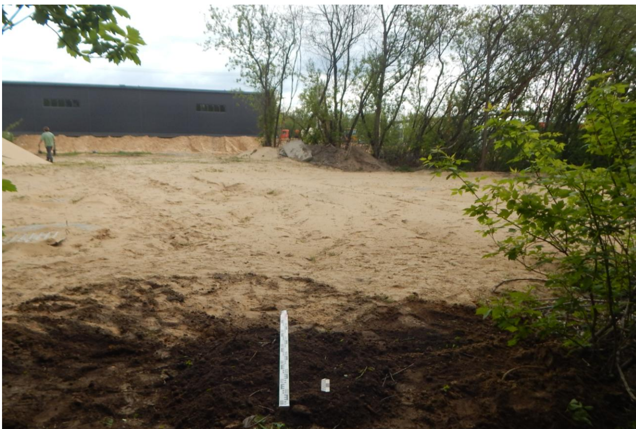
Рис. 16. Нижегородская область, г. Дзержинск, участок в районе д. № 2А по Речному шоссе. Разведочный шурф, рекультивация, вид с юга.
